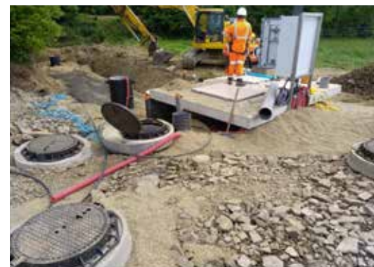
Réhabilitation du poste de relevage Commandant Le Jeune à Pleyber-Christ
