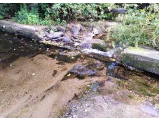
Seuil de la prise d'eau du moulin de Kernabat avant aménagement
