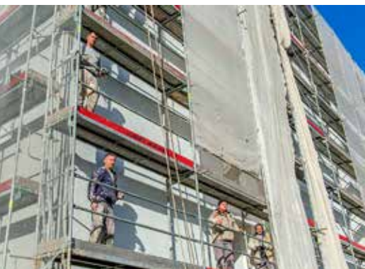
Logements en cours de rénovation
