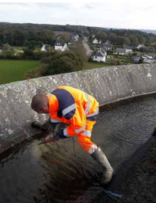
Intervention de l'équipe régie sur le réservoir de Plouigneau pour une opération de maintenance
