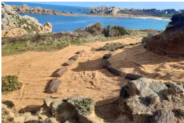
Pointe An Alouestenn, Plougasnou, pose de fibre naturelle et de coussins de brandes de bruyère sur les zones érodées, chantier mis en œuvre par les BTS GPN
