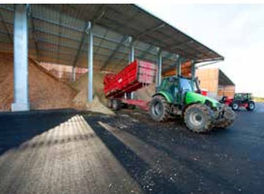
Plateforme bois énergie
