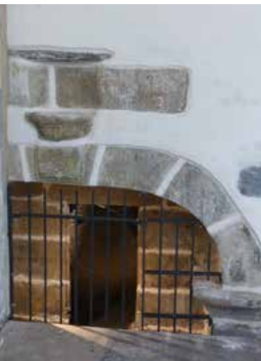
Rénovation de la fontaine - Comité de la Maison du Peuple
