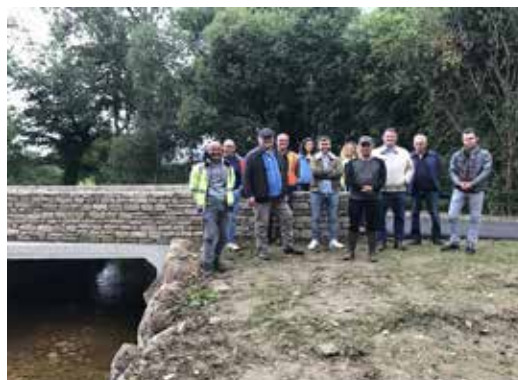
Vue du pont de Cann Bras après aménagement
