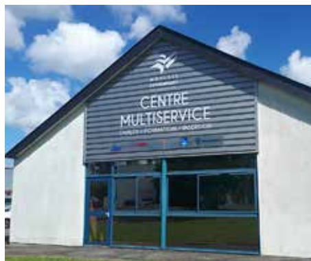
Façade du Centre multiservice à la Boissière
