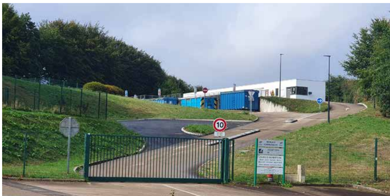
Accès général de la déchèterie de Plougonven
