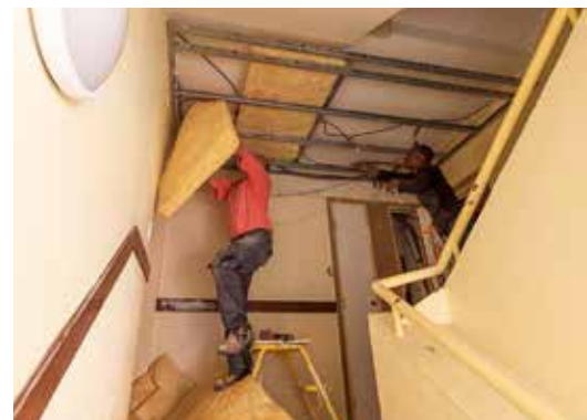
Opération de rénovation
