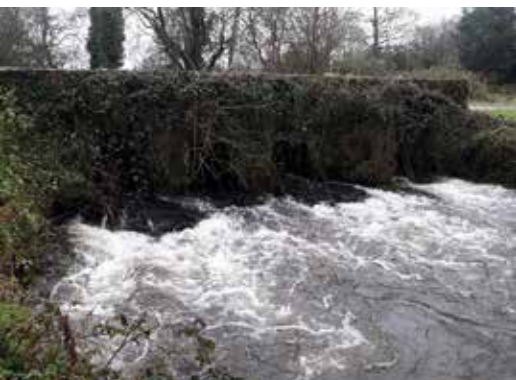
Vue du pont de Cann Bras avant aménagement
