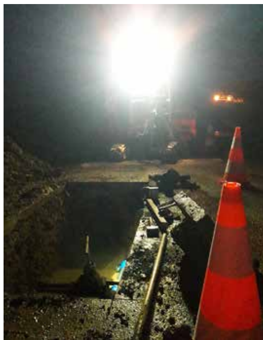
Intervention de nuit de l'équipe régie pour une réparation du réseau d'eau potable à Plougonven
