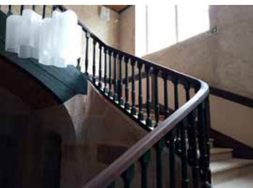
Rénovation de l'escalier dans la Manufacture des tabacs
