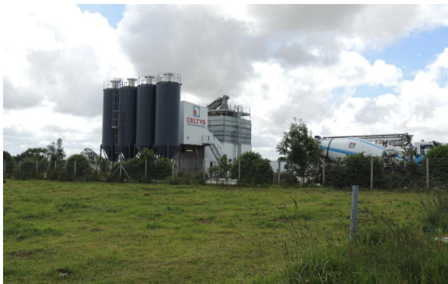
2- La centrale béton, située en face de la ZA des Ajoncs
