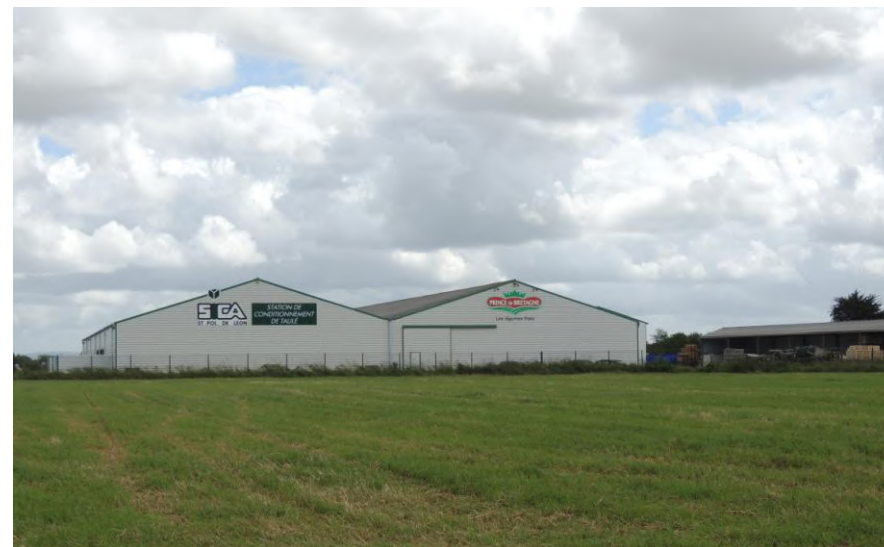
3- Les installations de la SICA de Saint-Pol-de-Léon, implantée au sud
