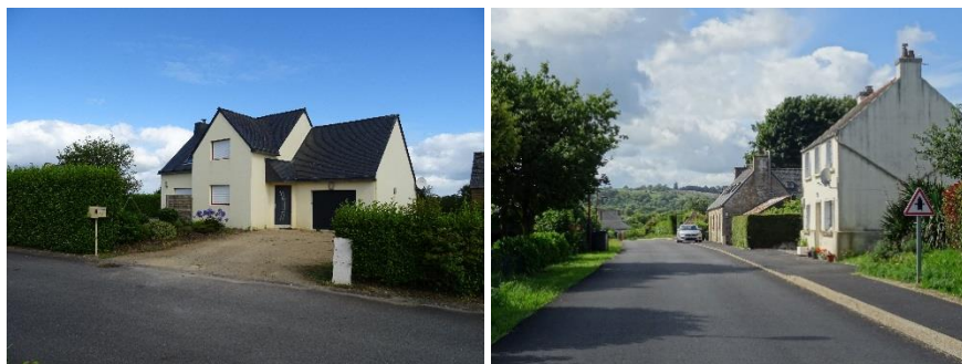
1. et 2. Vues vers les habitations jouxtant le site
