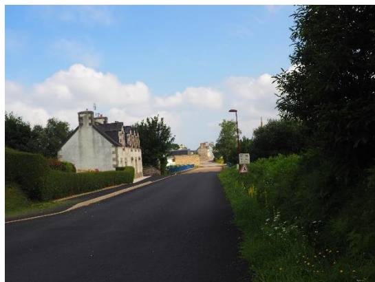
Voie d'accès au site et au centre-bourg (©Territoire +)
