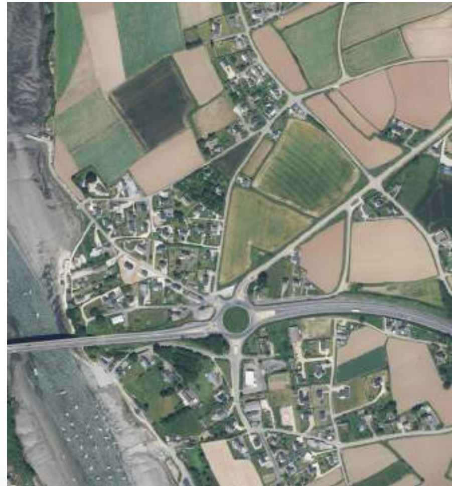
Secteur du Pont de la Corde
