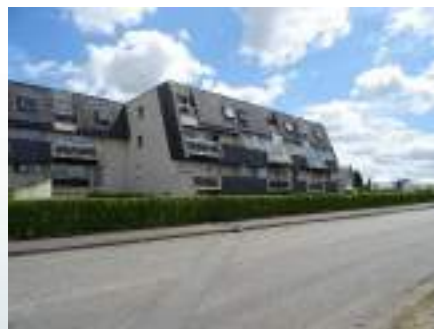
1. Vue vers les immeubles d'habitation
