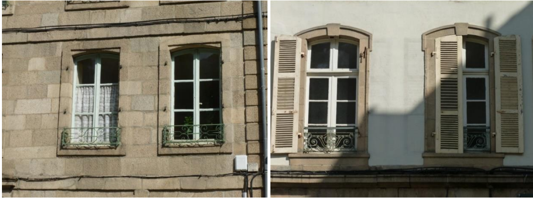
Place Cornic et place des Otages
