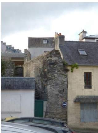
Partie de la muraille / Place de la Fontaine au Lait
