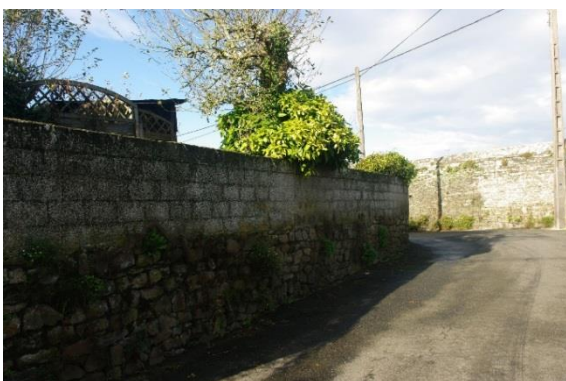
Surélévation des murets par des rangs de parpaings
