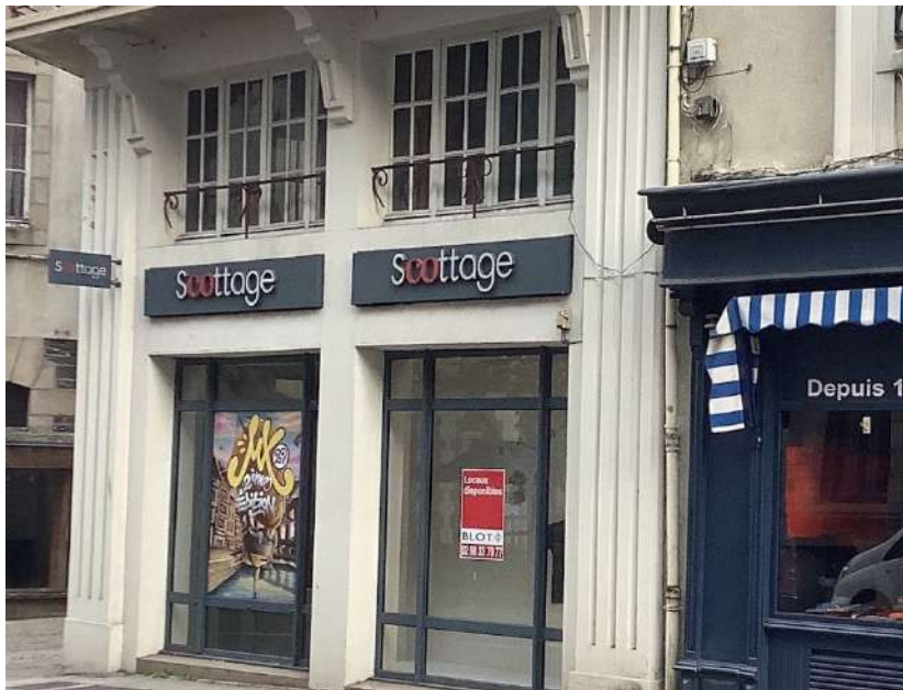
Enseignes parallèles sur panneau sur fond en site patrimonial remarquable, Morlaix, novembre 2020.
