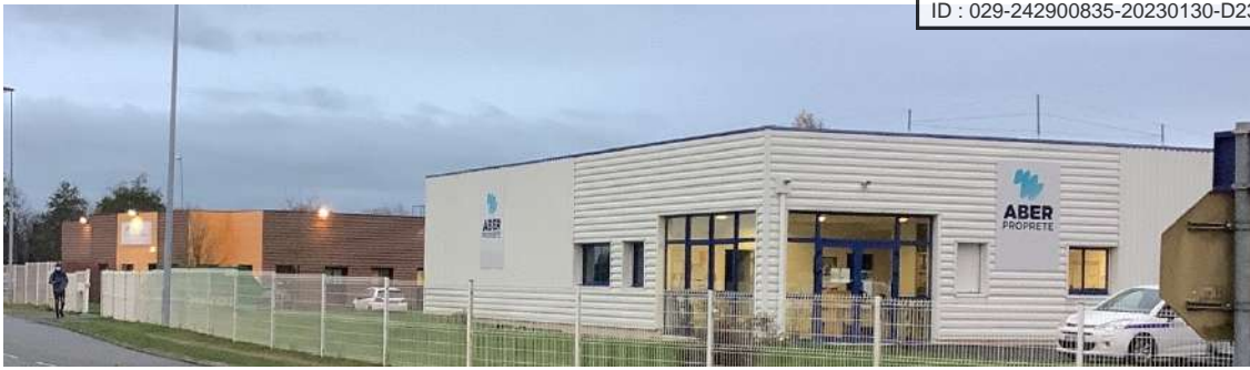
Enseignes parallèles au mur en zone d'activités, Morlaix, novembre 2020.
