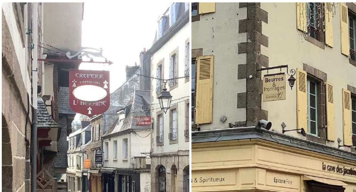
Enseignes perpendiculaires au mur en fer forgé situées en site patrimonial remarquable, Morlaix, novembre 2020.
