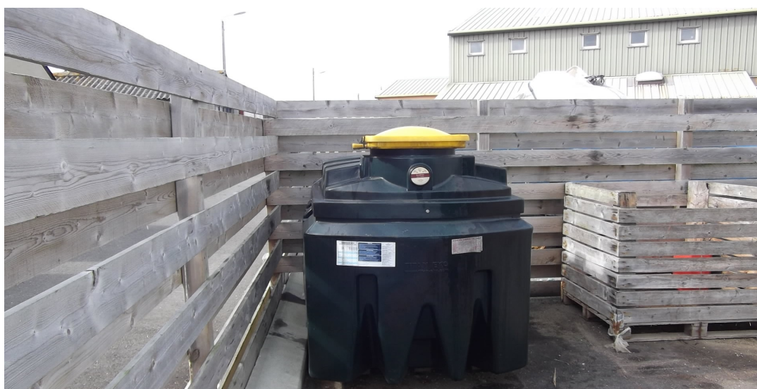
Cuve étanche de 1200l double paroi pour huiles usagées
