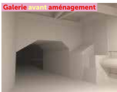
Galerie avant aménagement
